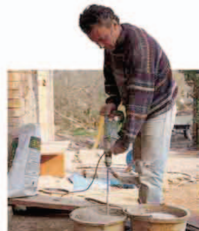
le maçon construction worker
