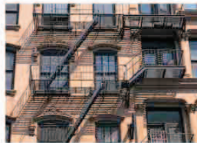
l'escalier de secours fire escape
