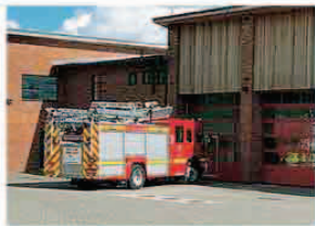
le poste d'incendie fire station
